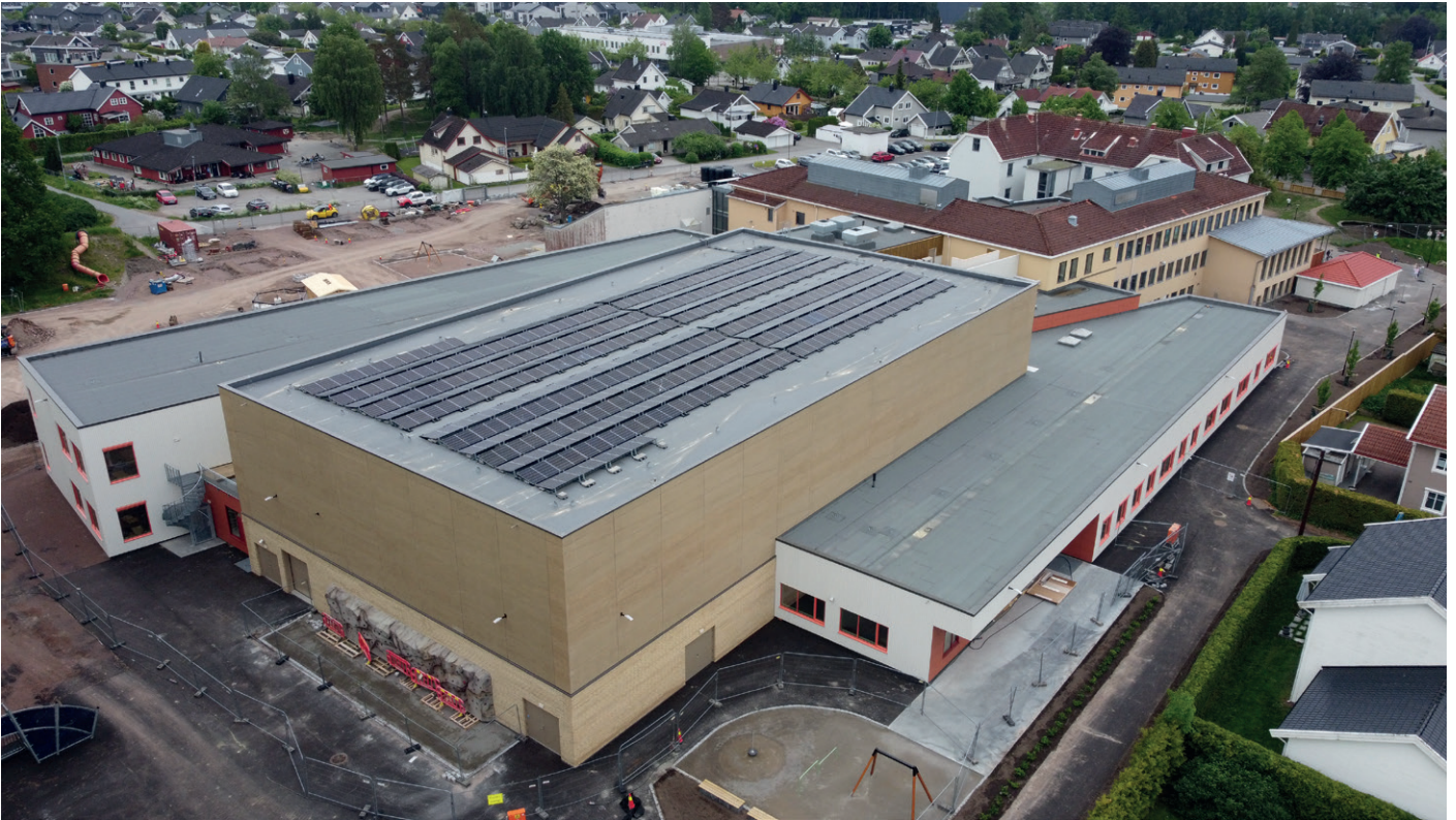
Backe Vestfold Telemark bygd en ny skolefløy på rundt 4.300 kvadratmeter.
